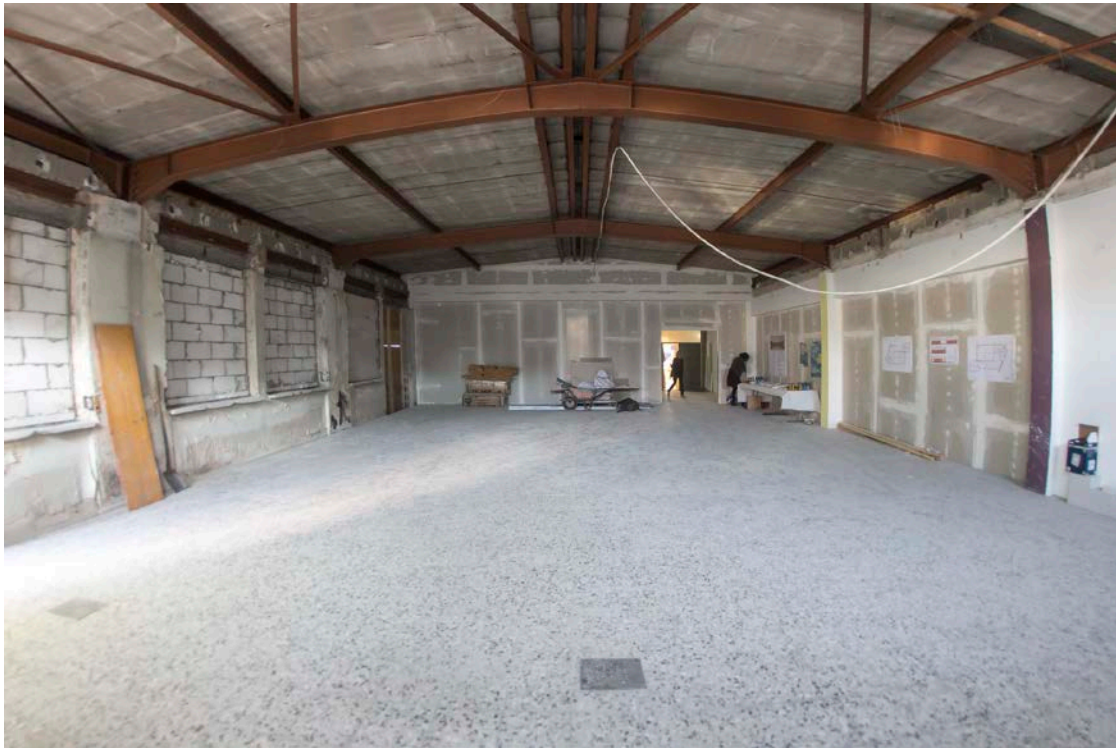
Umbau einer ungenutzten Lagerhalle
